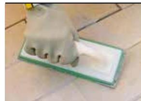
• Miscelando **webercolor basic** con il lattice **weber L50**, in totale sostituzione all'acqua di impasto si ottiene un prodotto ad elasticità, flessibilità ed idrofugazione migliorate, tali da consentire l'applicazione in piscine, facciate, terrazzi e bagni. Nel caso di superfici rugose, porose, cotto, gres levigato, si consiglia di eseguire una prova preliminare di pulizia.
