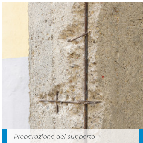
Passivazione dei ferri di armatura con Mapefer 1K
