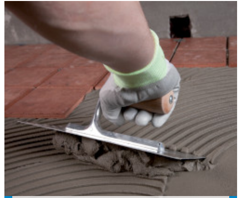
Posa di Granirapid su terrazzo impermeabilizzato con Mapelast
