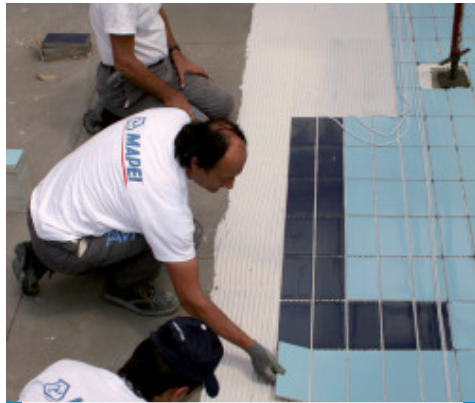
Posa di rivestimento ceramico su Mapelast
