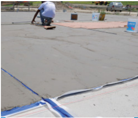
Impermeabilizzazione dei massetti con Mapelast e Mapeband
