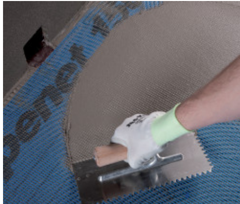
Stesura di Mapelast su Mapenet 150
