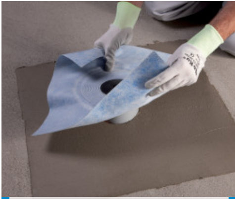
Posa di Drain Vertical, pozzetto di scarico, su Mapelast
