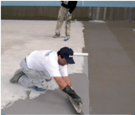
Impermeabilizzazione di una piscina con Mapelast
