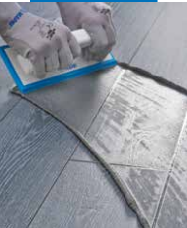
Stesura di Ultracolor Plus a pavimento con spatola di gomma su piastrelle in gres porcellanato effetto legno
