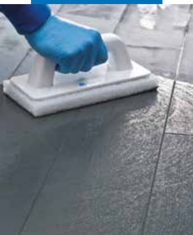
Pulizia delle fughe con Scotch-Brite® (a prodotto parzialmente indurito)
